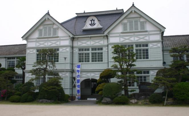
旧邊喬尋常小学校
