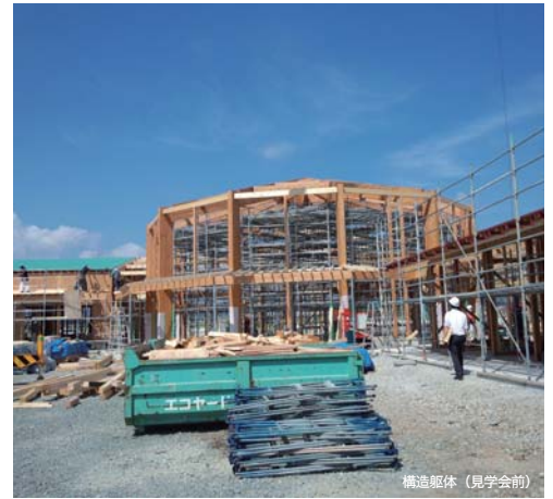
構造躯体 (見学会前)
